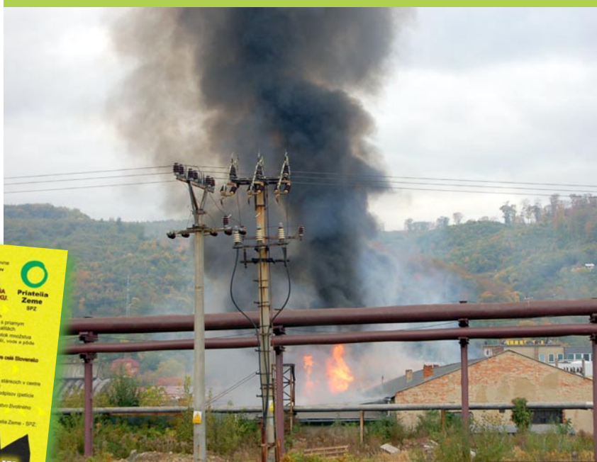
Požiar skladu nebezpečných odpadov v prešovskej spaľovni
